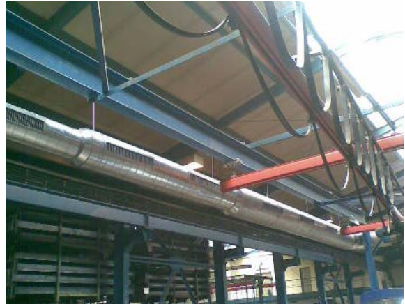
Detail výfukového kanálu a nasávacích mřížek.
