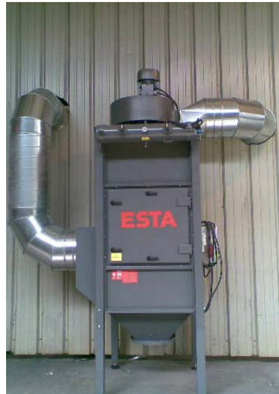
Instalace centrálního, filtračního modulu ESTA DUSTEX – F 84 .
