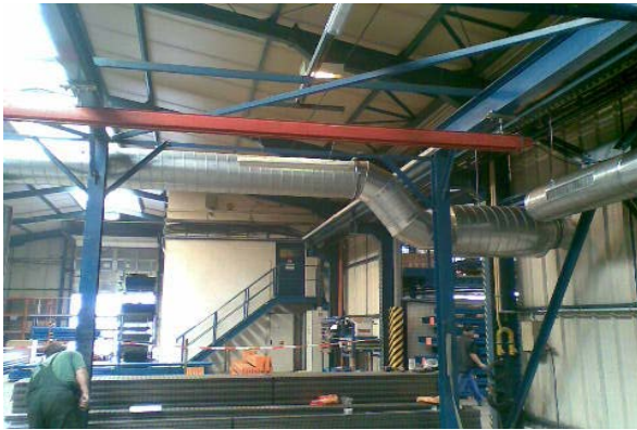
Pohled na aplikaci PUSH PULL metody. Odsávací zařízení je připojeno k napájení a k rozvodu stlačeného vzduchu.
