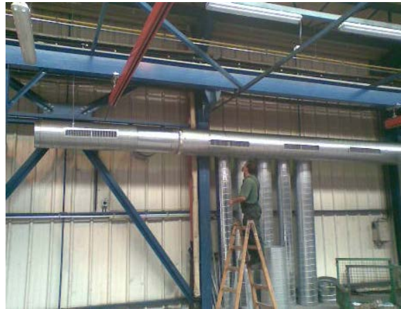
Montáž potrubního rozvodu, průřez potrubí od 315 do 500 mm.
