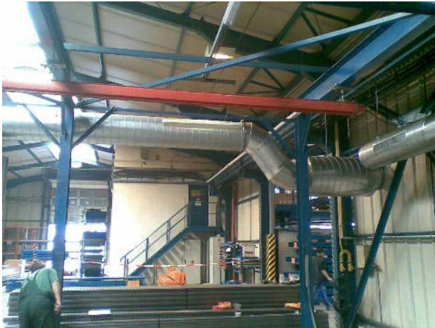
Potrubi rozvod, lehké ocelové SPIRO potrubí, tvarovky s pryžovým těsněním.
