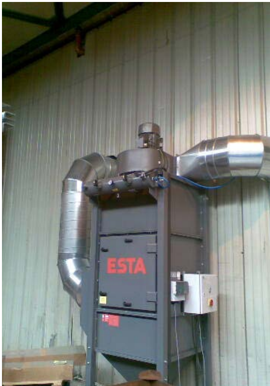
Detail ovládací jednotky pro filtrační modul ESTA DUSTEX – F 84 .
