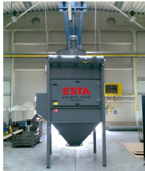
Instalace centrálního, filtračního modulu ESTA DUSTEX – F 144 .
