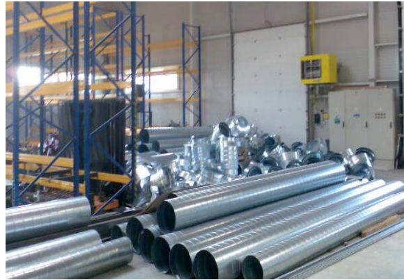
Materiál pro montáž cca. 1,2 km potrubního rozvodu, průřez potrubí od 315 do 560 mm.
