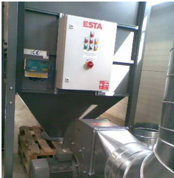
Detail ovládací jednotky pro filtrační modul ESTA DUSTEX – F 144 .
