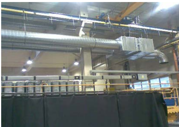
Obr. 5. Detail bočních výfukových kanálů, 7 linií každá o délce cca. 45 m.
