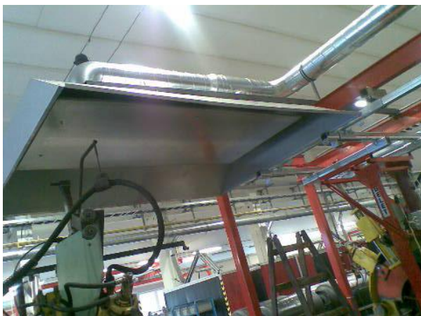
Obr. č. 3 Odsávací digestoř 2.000 x 1.000 mm. Odsávací digestoř je vybavena středovým plechem pro zvýšení odsávacího účinku.
