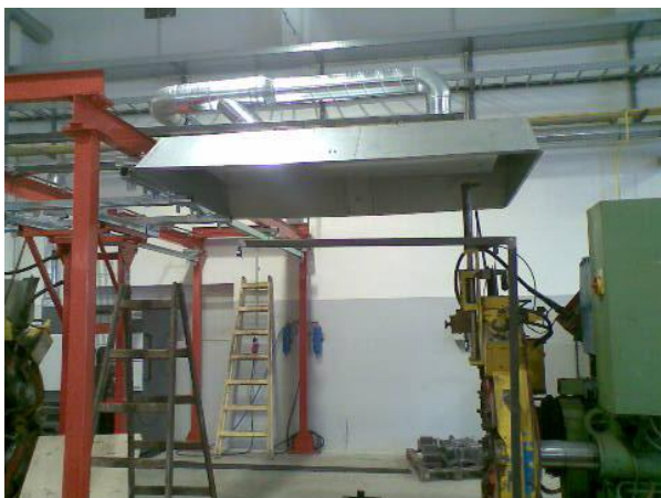
Obr. č. 1 Instalování odsávací digestoře nad robotizovaným svařovacím pracovištěm. Odsávací digestoř je ukotvena k ocelové konstrukci.
