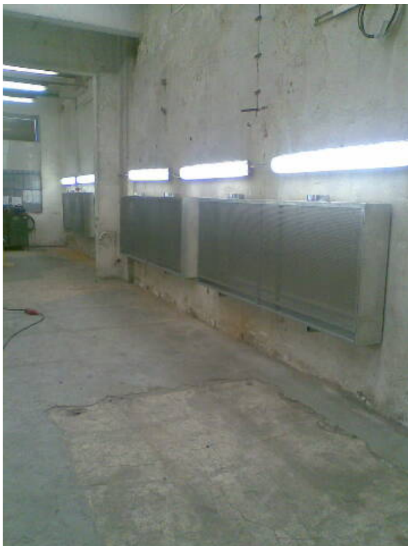
Velkoplošné odsávací stěny 3.000 x 1.000 mm – detail.
