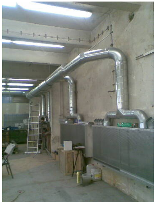
Velkoplošné odsávací stěny – napojení do odsávacího kanálu.
