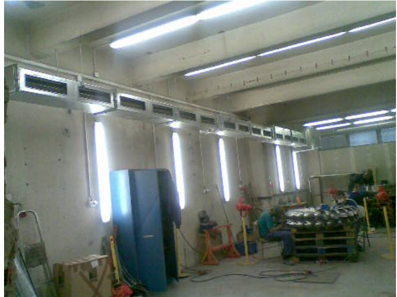
Pohled do výrobního prostoru. U větších dílů mnohdy pracuje i několik pracovníků současně. Dochází ke tvorbě vysokých prachových koncentrací. V horní části je zpětný kanál s výfukovými mřížkami.
