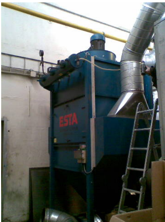
Montáž odsávací jednotky ESTA DUSTEX F – 144.
