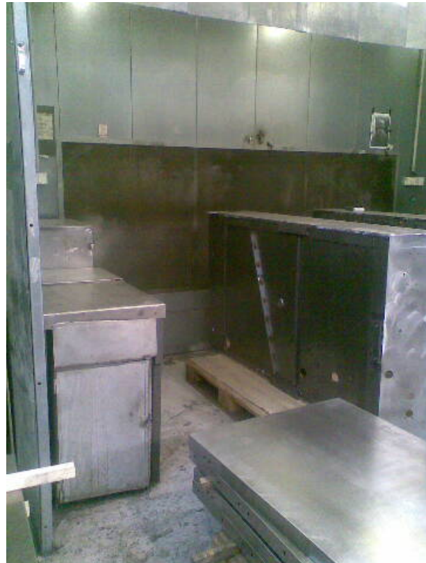
Detailní pohled do boxu, v pozadí odsávací stěna.
