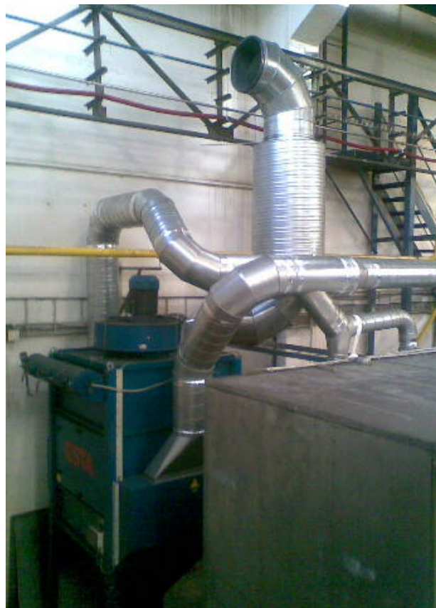
ESTA DUSTEX F – 144 – detail automatiky pro čištění filtračních patron. Rozvod vzduchotechnického potrubí.
