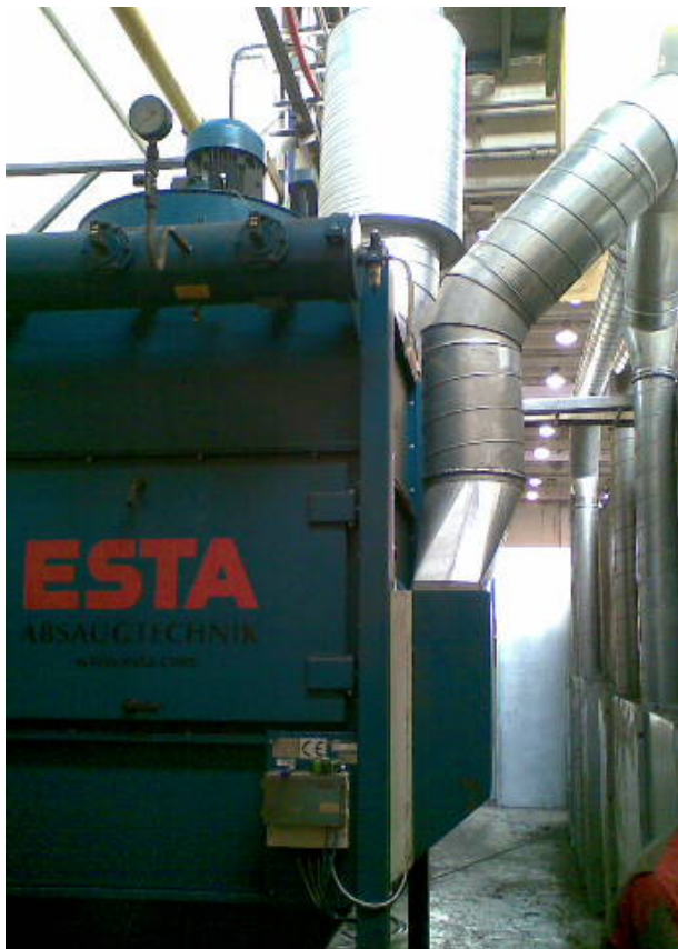
ESTA DUSTEX F – 144 – detail automatiky pro čištění filtračních patron. Rozvod vzduchotechnického potrubí.
