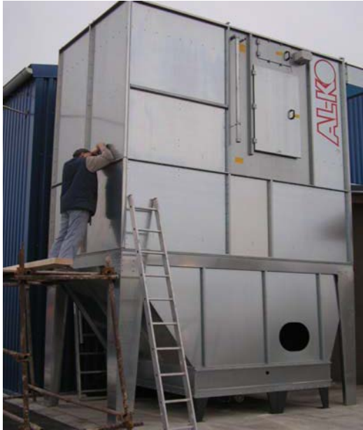
Instalování centrální odsávací jednotky AL – KO ECO JET – 20.000 m 3 /hod. Jednotka je vybavena briketovacím lisem.
