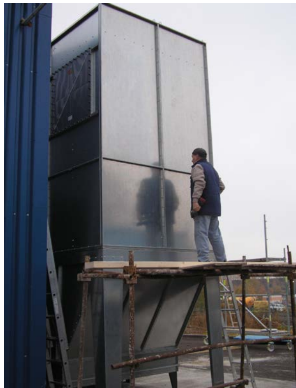
AL-KO ECO JET DUO – stavba. Vzhledem ke hmotnosti a celkové výšce odsávacího modulu je nutné využívat manipulační a montážní techniku.
