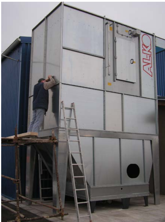
AL-KO ECO JET DUO – stavba. Montážní technik provádí šroubové spojení jednotlivých dílů.
