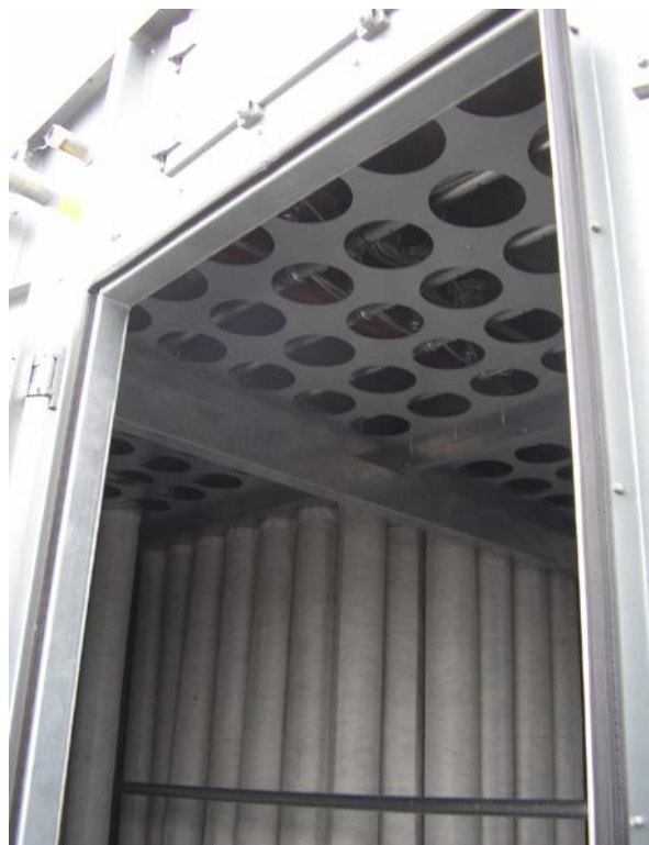
Montáž filtračních rukávů - detail.
