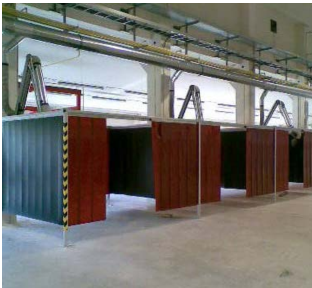
Výstavba centrálního potrubního rozvodu – lehké SPIRO potrubí, tvarovky s pryžovým těsněním
