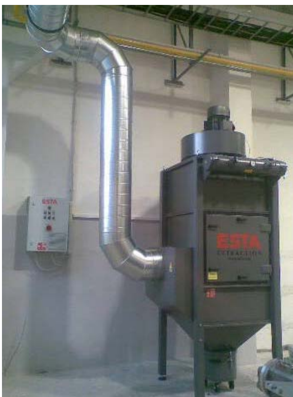
Centrální odsávací a filtrační zařízení ESTA DUSTEX F – 84 se speciálními, filtračními, polyesterovými patronami. Zařízení je připojeno k napájení a k rozvodu stlačeného vzduchu. Ve spodní části je pojízdný, sběrný zásobník na odsátý odpad a k filtru je připevněn speciálními klipy. Na čelní stěně jsou inspekční dveře. Z levé strany vstupuje potrubní rozvod do jednotky.
