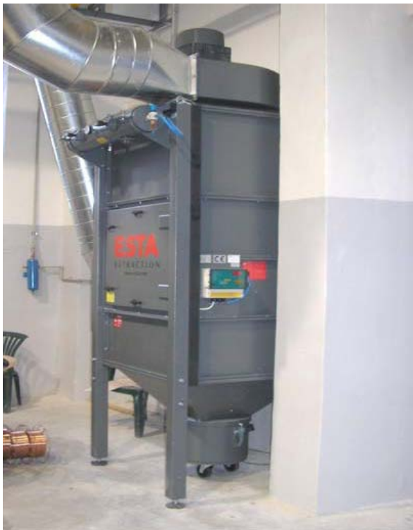
ESTA DUSTEX F – 84 boční pohled na řídicí modul MECAIR, ovládání, tlumič hluku a přípojku stlačeného vzduchu. Ve spodní části je pojízdný, sběrný zásobník na odsátý odpad a k filtru je připevněn speciálními klipy. Na čelní stěně jsou inspekční dveře.
