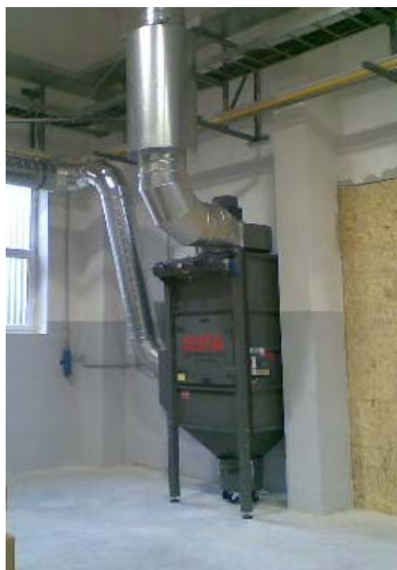
ESTA DUSTEX F – 84 boční pohled na řídicí modul MECAIR, ovládání, tlumič hluku a přípojku stlačeného vzduchu. Přídavný tlumič hluku snižuje úroveň hlučnosti.
