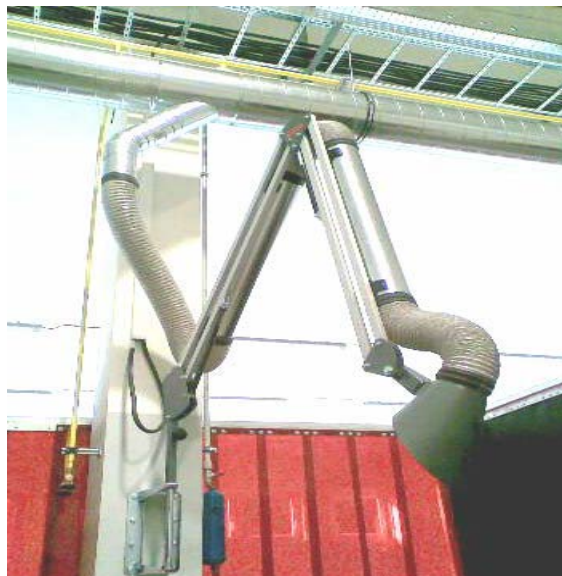
Montáž odsávacího ramene DN 140 mm, délka 3 m – detail
