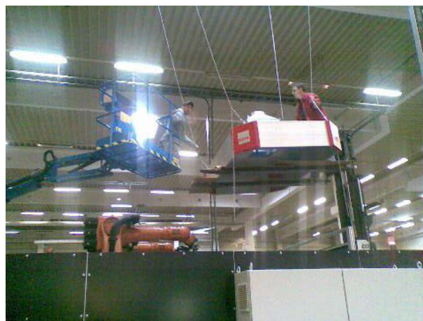
Instalování odsávací digestoře nad robotizovaným svařovacím pracovištěm. Odsávací digestoř je vyvěšena na ocelových řetízcích ukotvených do trapézového stropu výrobní haly. Při montáži odsávacích digestořů je využívána manipulační a zdvihací technika.
