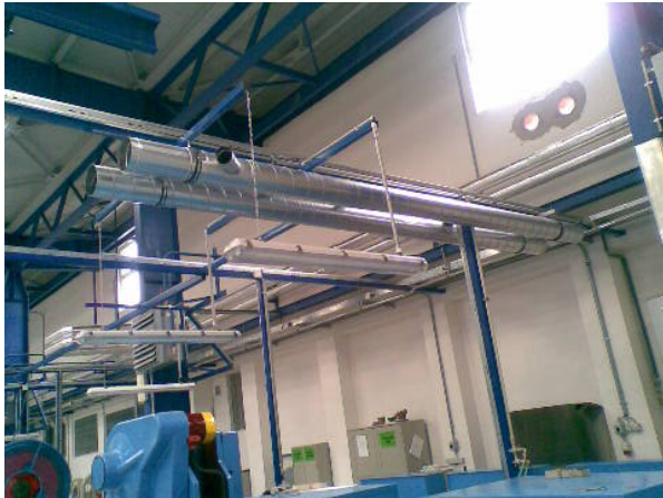
Výstavba odsávacích tras. Odsávací trasy jsou zhotoveny z ocelového SPIRO potrubí.
