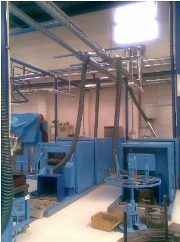
Celkový pohled na pracoviště po montáži. Koncová místa jsou spojena flexibilními PU hadicemi.
