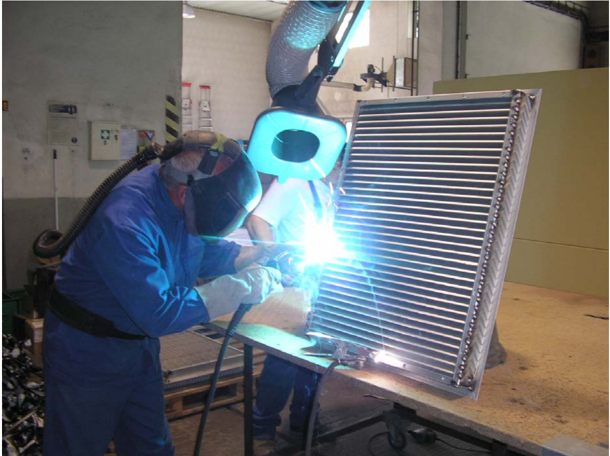
Detail dymníku a odsávání vygenerovaných dýmů.
