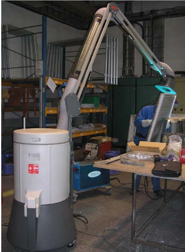
Celkový pohled do prostoru svařovacího pracoviště. V popředí je odsávací komplet SRF K 15 s rozloženým ramenem nad zájmovým prostorem.
