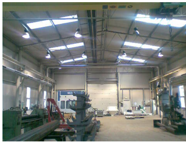
Pohled do svařovny - montáž odsávání. Vlevo výfukový kanál, vpravo nasávací kanál.
