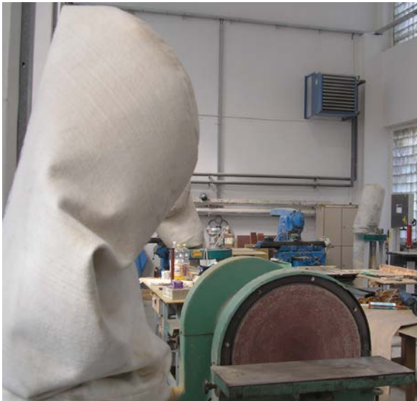
Obr. 1. Celkový pohled na dílnu – odsávání od strojů lokálními pytlými odsavači.
