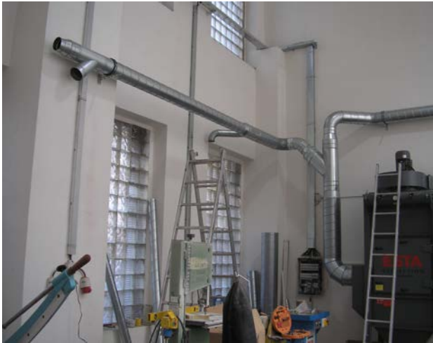
Výstavba centrálního potrubního rozvodu – lehké SPIRO potrubí, tvarovky s pryžovým těsněním
