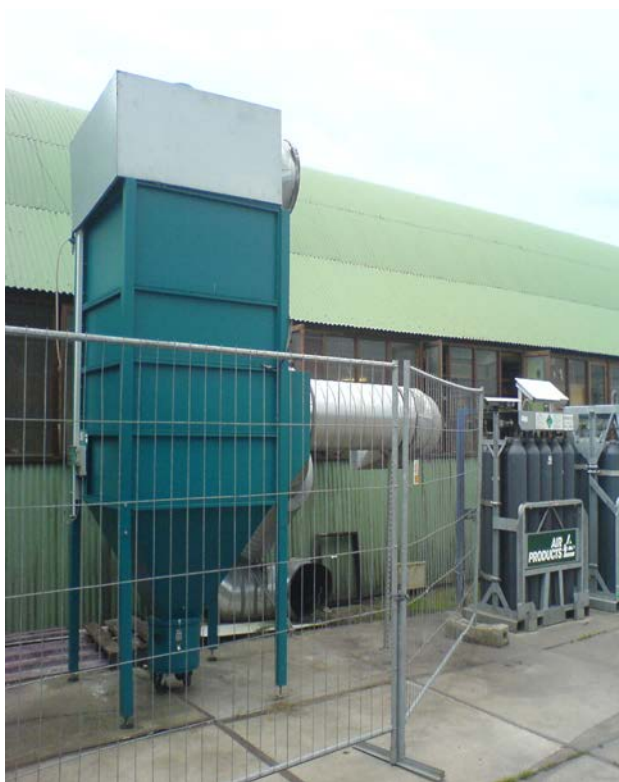
Venkovní instalace odsávacího modulu ESTA DUSTEX F 189 (montáž). Nad filtračním modulem je umístěn odsávací ventilátor 18,5 kW. Pro snížení akustického hluku je kolem ventilátoru nainstalováno protihlukové opláštění.
