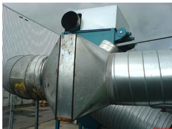
Lapač žhavých částic, detail.
