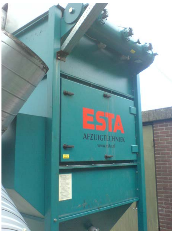
ESTA DUSTEX F 189. Pohled na filtrační skříň. Velká inspekční vrata umožňují pohodlnou výměnu filtračních segmentů. V horní části je zásobník na tlakový vzduch pro čištění patron s elektropneumatickými ventily.
